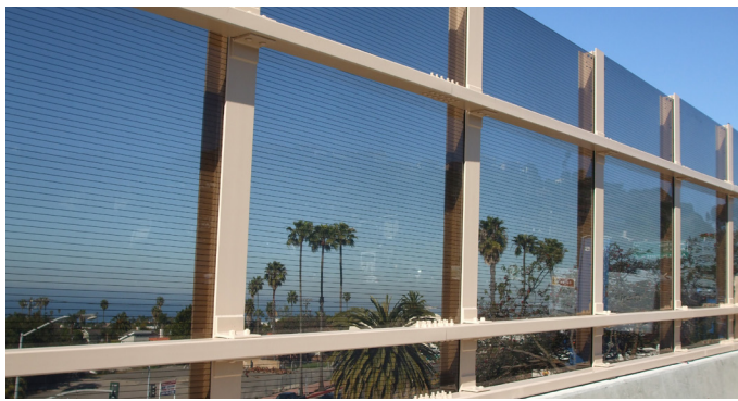
INTERSTATE 5 OVER EL CAMINO REAL - SAN CLEMENTE, CA
